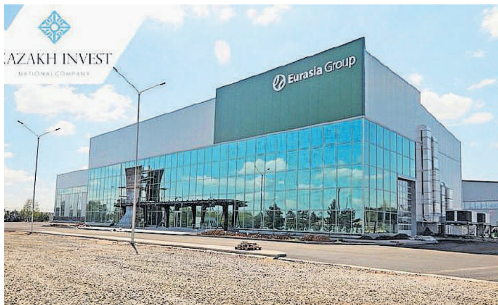
Hier Briefkasten, dort Glasfront: Service-Center für Traktoren in Kokshetau.
