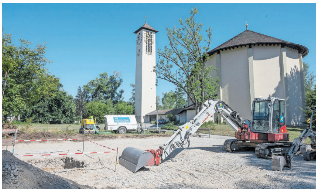
Ein Bagger vor der Steigkirche.
