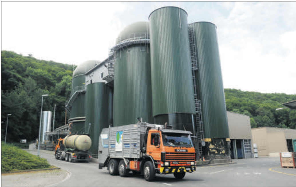
Keine Einigung: Die Biogasanlage wird nicht verkauft.
